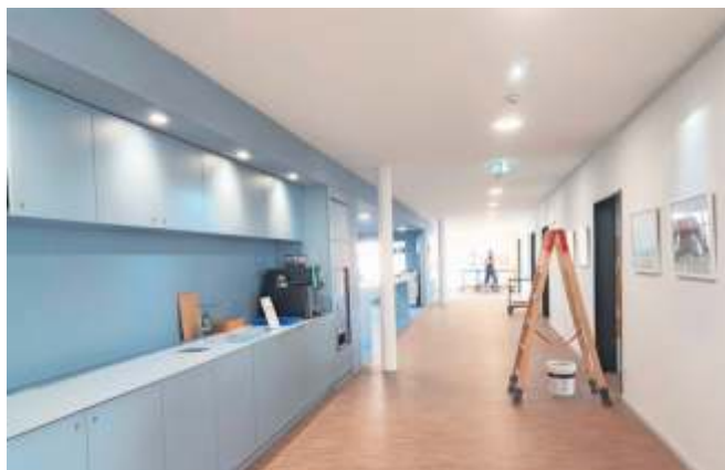
Auch wenn noch letzte Arbeiten zu erledigen sind, werden die neuen Räume der VHS schon genutzt. Fotos: Laartz
