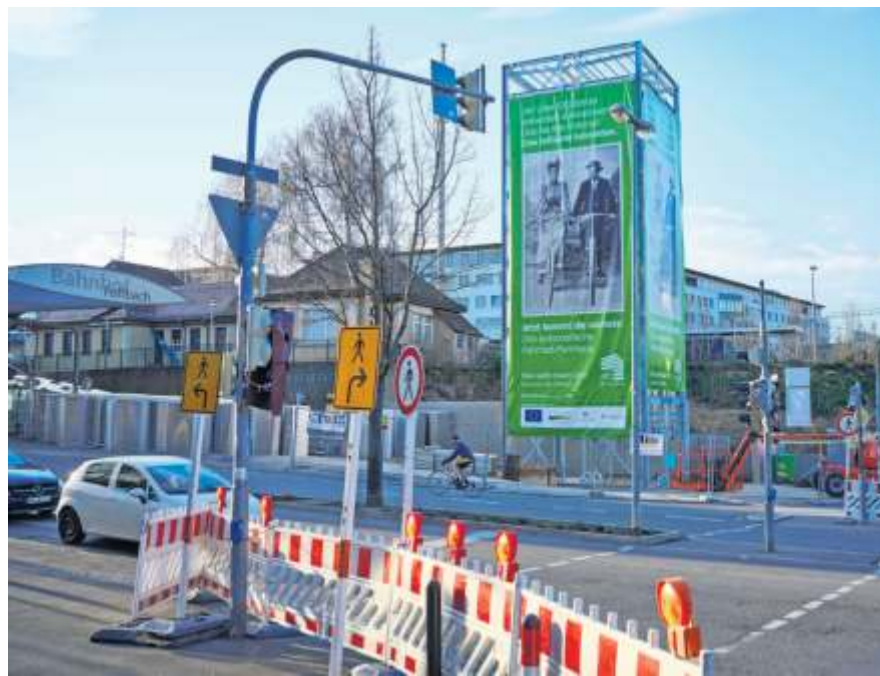
Die Montagearbeiten am Fahrradparkhaus ruhen zur Zeit.
