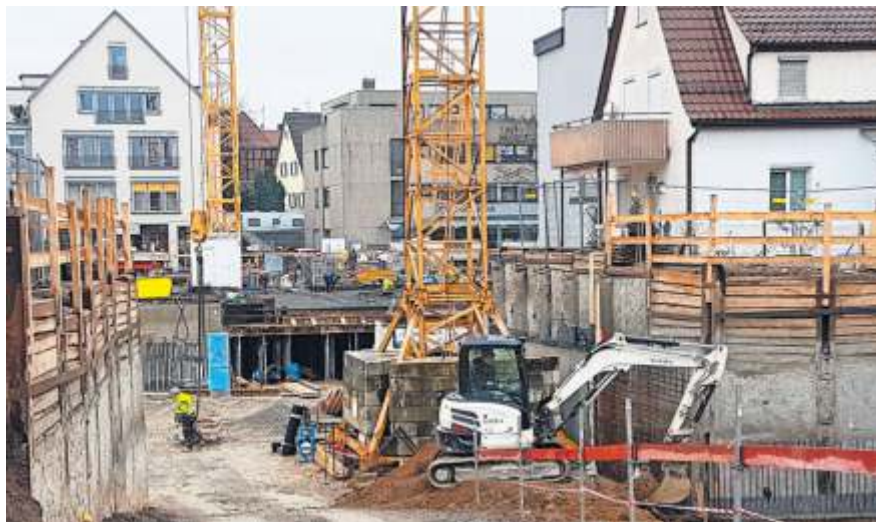
Die Arbeiten für die Neue Mitte Schmidens kommen gut voran.
