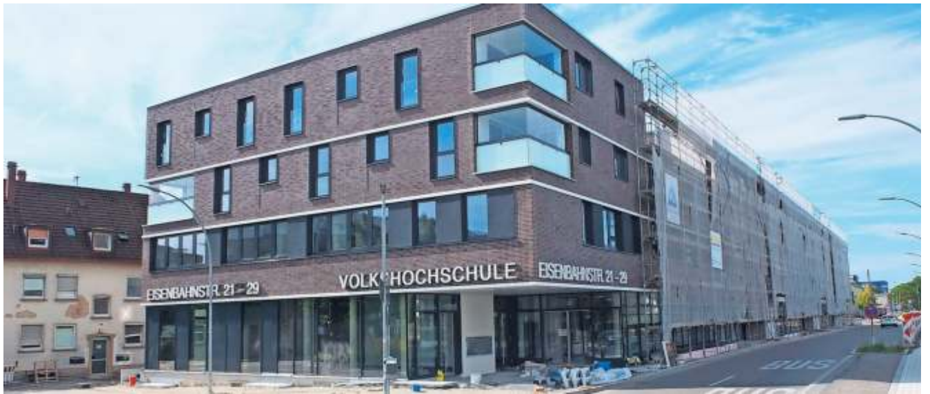
Die Arbeiten in der Eisenbahnstraße befinden sich in der Endphase.
