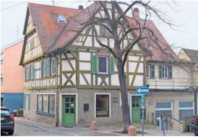
Das Gebäude Schmerstraße 10 soll modernisiert werden.
