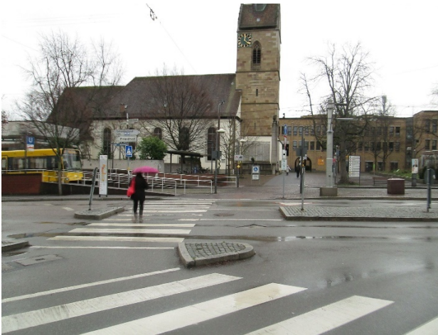
Abbildung 2: Beispiel für eine signalisierte Gleisquerung in unmittelbarer Nähe an der Lutherkirche
