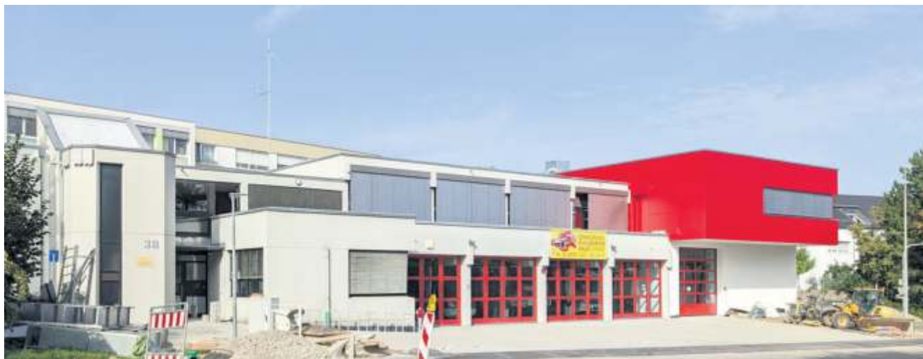
Am Sonntag wird der markante Anbau ans Feuerwehrhaus Schmiden eingeweiht.
