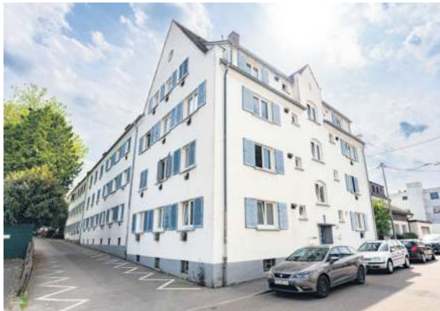
Noch in diesem Jahr soll mit der Komplettsanierung des Gebäudes in der Endersbacher Straße 10 begonnen werden. Foto: Marquardt
