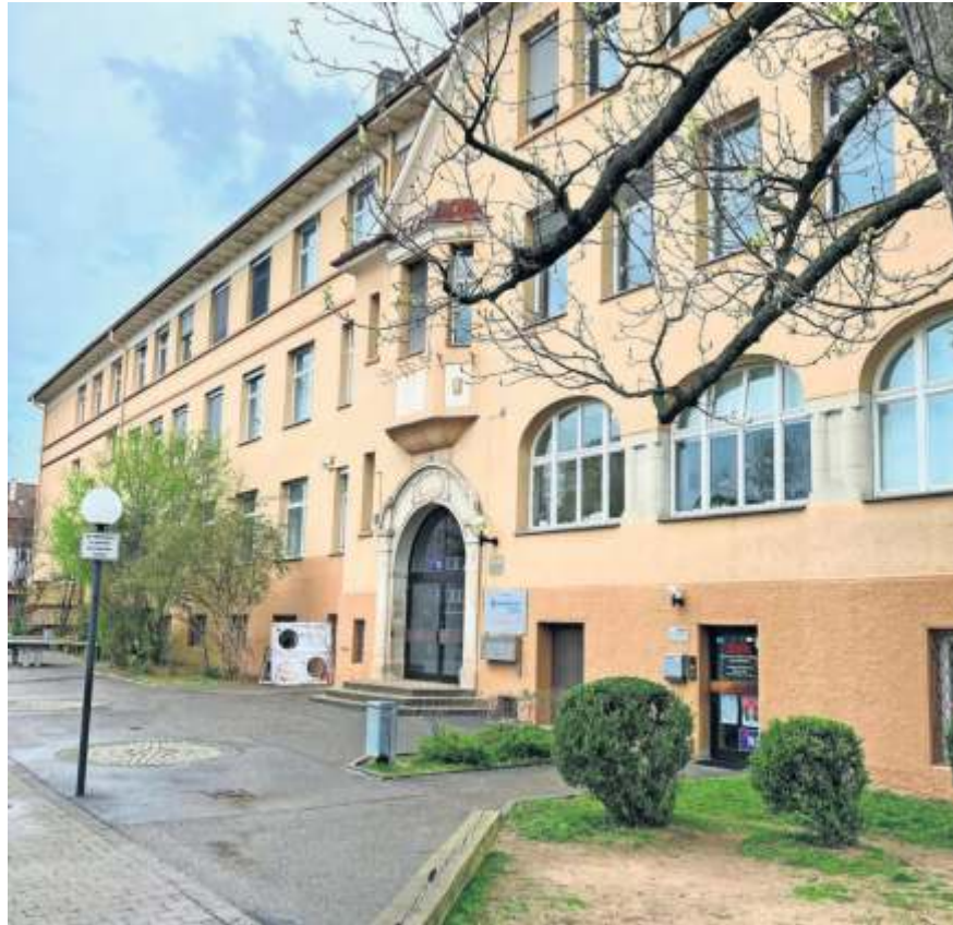
An der Wichernschule wurde aus einem Lernmittelraum in der Sommerferien ein hochmodernes Klassenzimmer. Foto: Tosun
