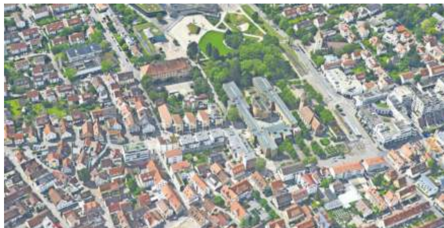
Wie wird die Wärmeversorgung der Stadt aussehen?
