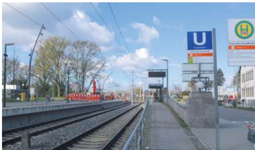
Ende September sollen die Arbeiten an der Haltestelle Schwabenlandhalle abgeschlossen sein.
