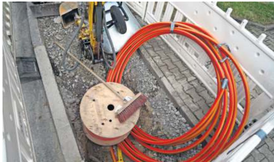
Der Glasfaserausbau in Fellbach geht weiter.
