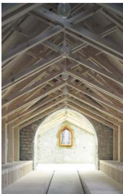
Eine durch einen Brand beschädigte Kapelle wurde beim Wiederaufbau zum Veranstaltungs- und Schutzraum für Wanderer. Foto: Waltefaugle
