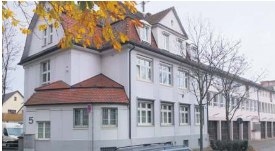
Am Cannstatter Platz sind Feuerwehr und Kriminalprävention unter einem Dach untergebracht. Foto: Knopp
