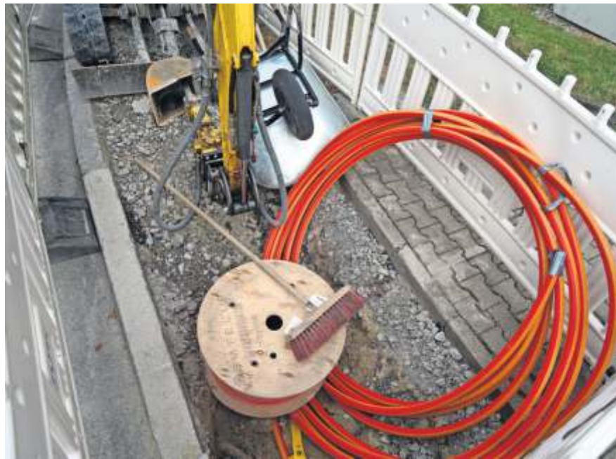
Auch in Oeffingen ist der Glasfaserausbau geplant.
