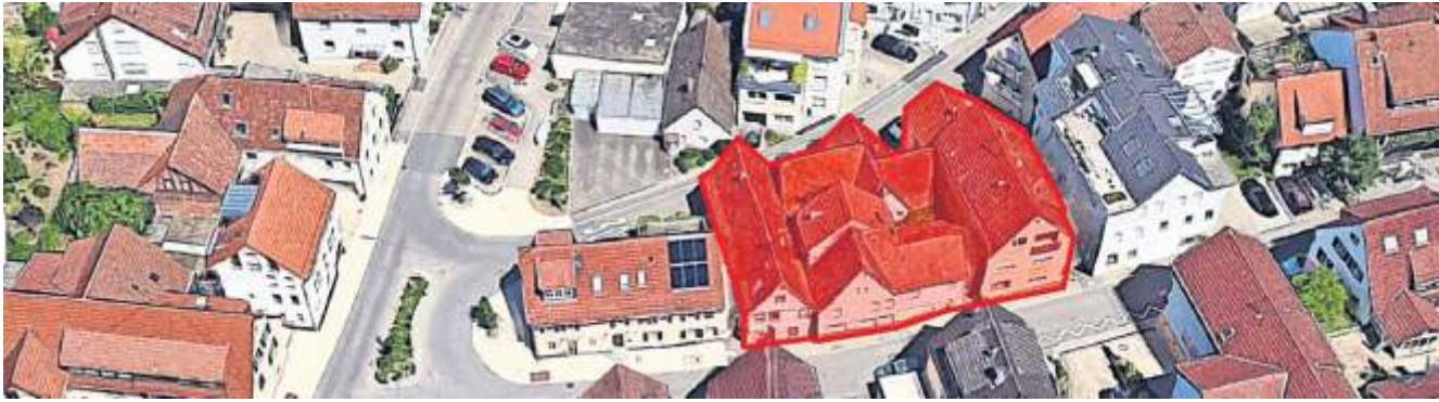
Das Weimer-Quartier aus der Luft betrachtet.
