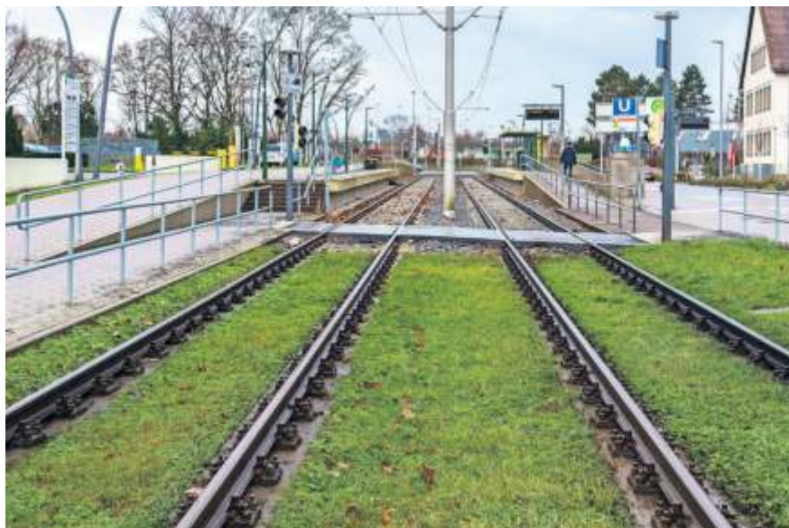
Die Haltestelle Schwabenlandhalle wird umgebaut.
