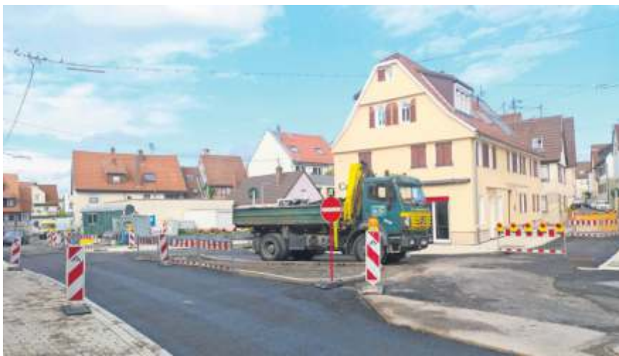
In der kommenden Woche wird der Endbelag eingebaut.
