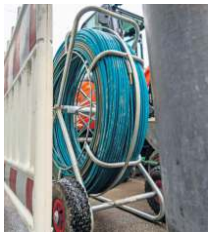
An vielen Stellen in der Stadt wird derzeit gebaut. Foto: Cojocar
