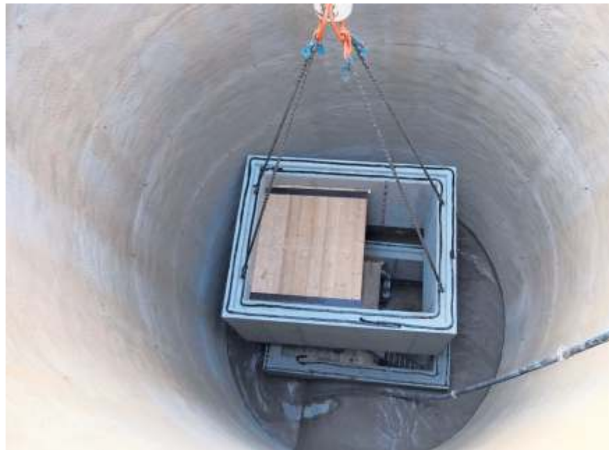
Anfang des Monats wurden die 32 Tonnen schweren Schachtteile in die Baugrube hinabgelassen. Foto: Knopp
