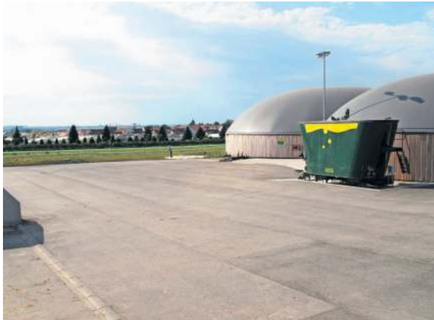
An der Biogasanlage waren Instandsetzungsarbeiten notwendig.
