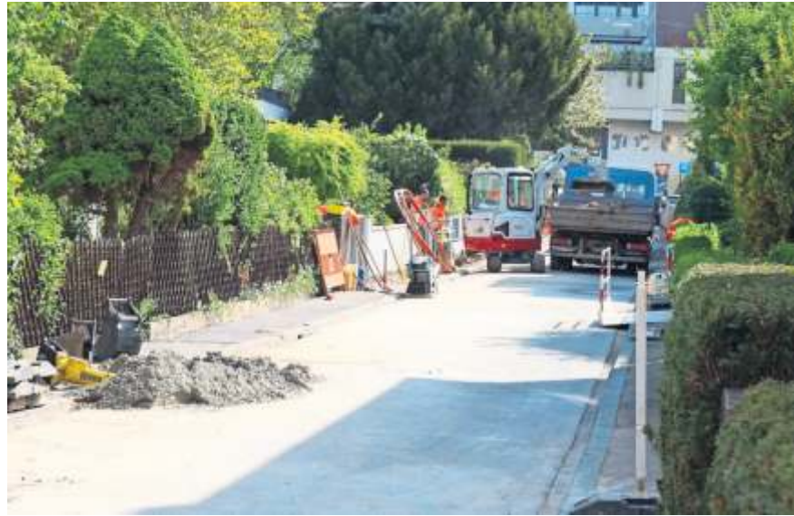
Mit Hochdruck wird am Ausbau des Glasfasernetzes gearbeitet.
