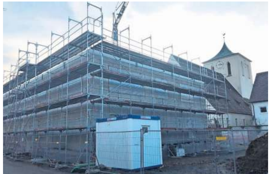
Der Rohbau fürs Stadtteil- und Familienzentrum steht.
