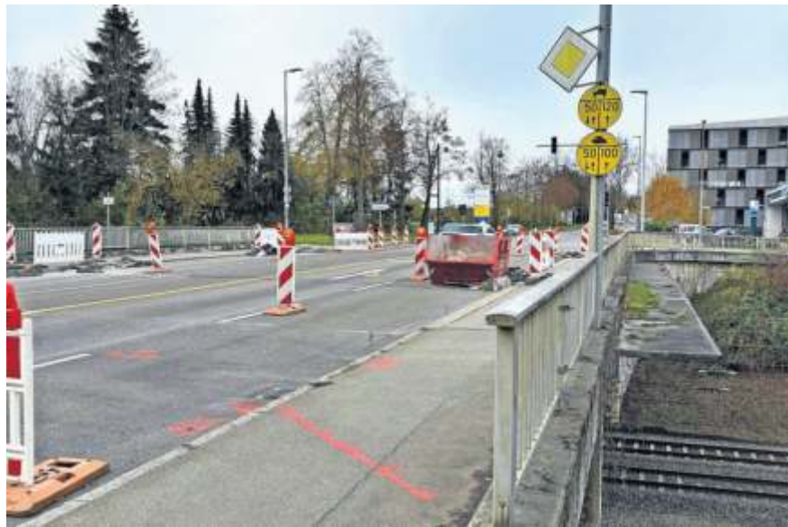
Geh- und Radweg mussten auf die Straße verlegt werden.
