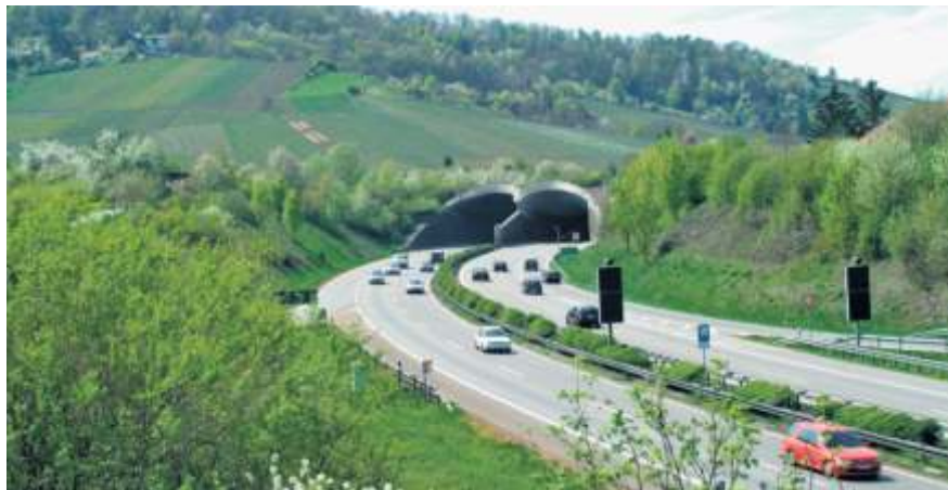
Der Kappelbergtunnel soll ertüchtigt werden.
