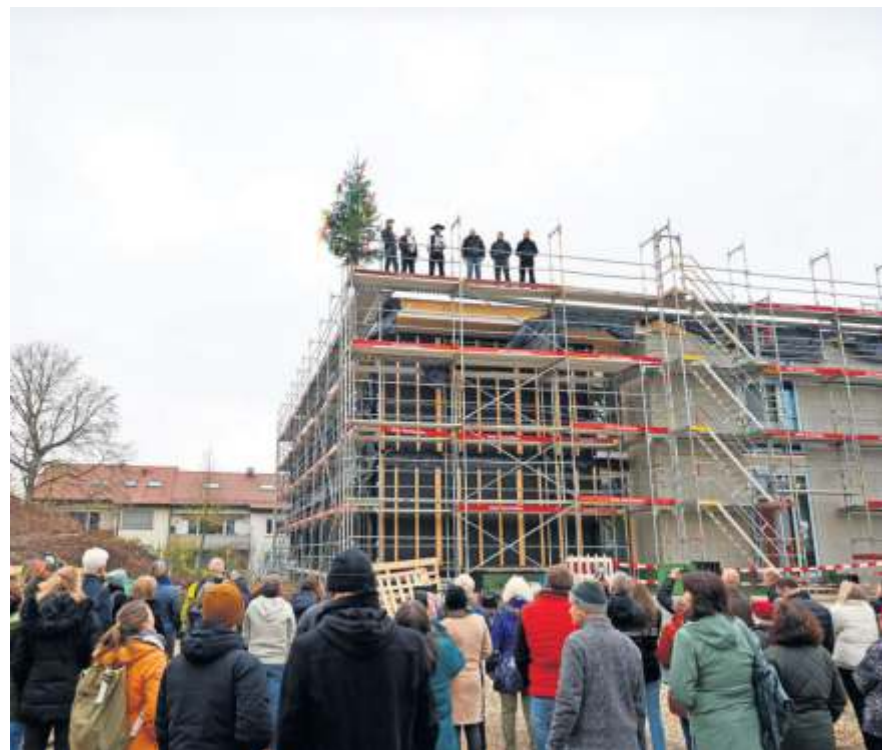
Der Rohbau für den Melanchthon-Kindergarten steht.
