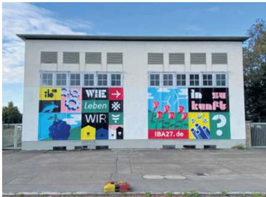
Das Umspannwerk wurde zum „Eyecatcher“.
