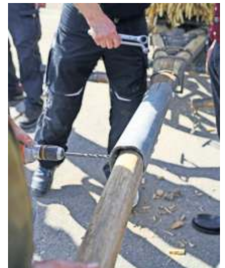
Die Mitarbeiter vom Bauhof konnten die Deichsel reparieren.
