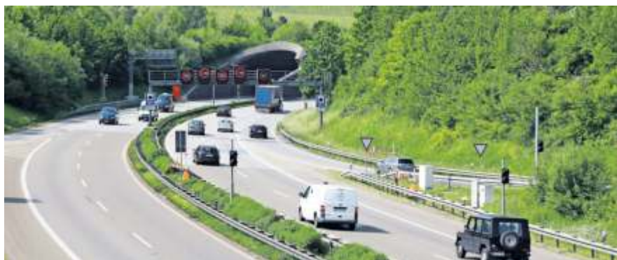
Im Kappelbergtunnel finden Reinigungsarbeiten statt.
