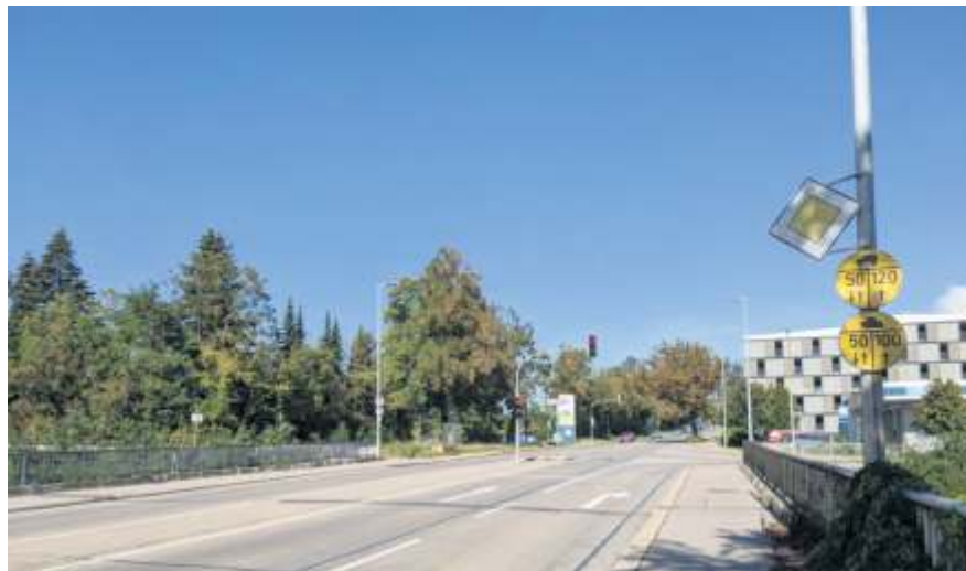
Die Brücke über die Eisenbahngleise muss saniert werden.
