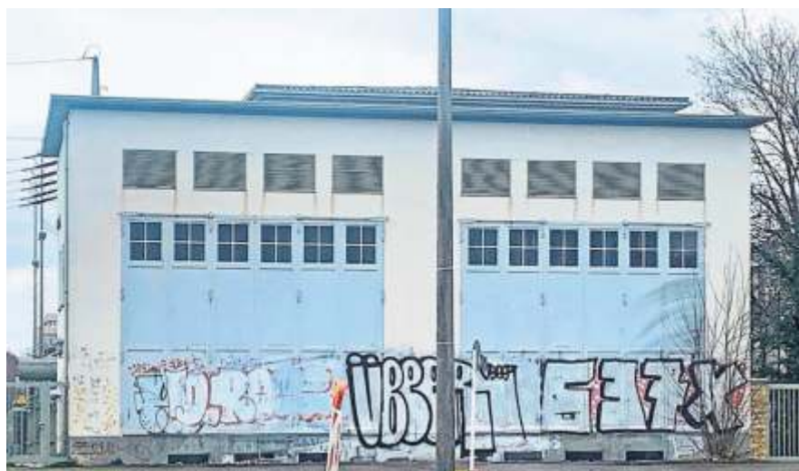
Umspannwerk in der Stuttgarter Straße.
