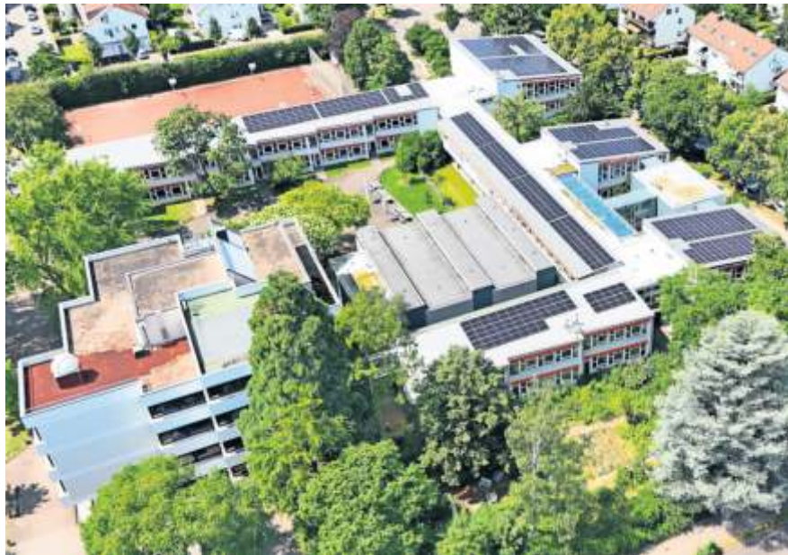
452 Solarmodule wurden auf dem FSG-Dach installiert. Foto: Stadtwerke Fellbach
