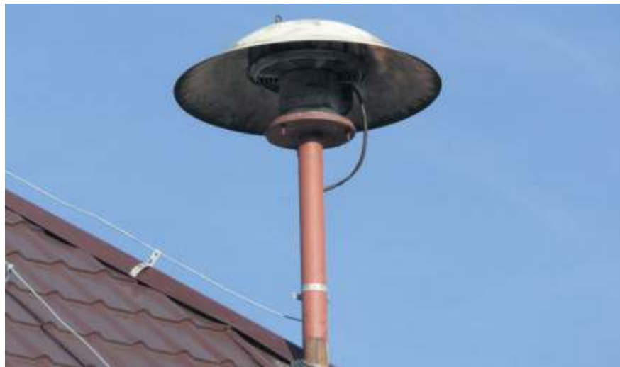
Vier Sirenen werden installiert.
