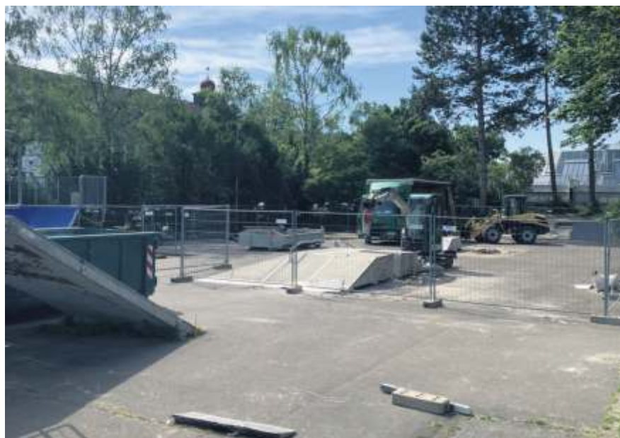
Mit dem Abbau der alten Geräte startete der Umbau.
