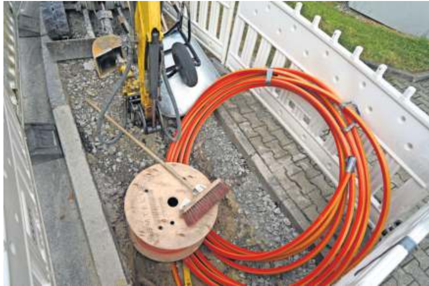
Bis 2025 soll Fellbach flächendeckend mit Glasfaser erschlossen sein. Foto: Archiv
