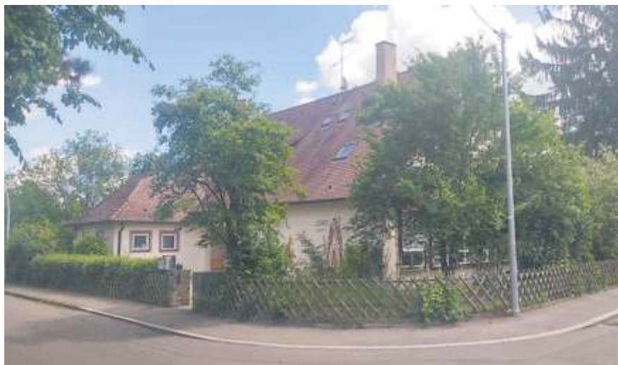
Der Gustav-Werner-Kindergarten erhält einen Neubau.
