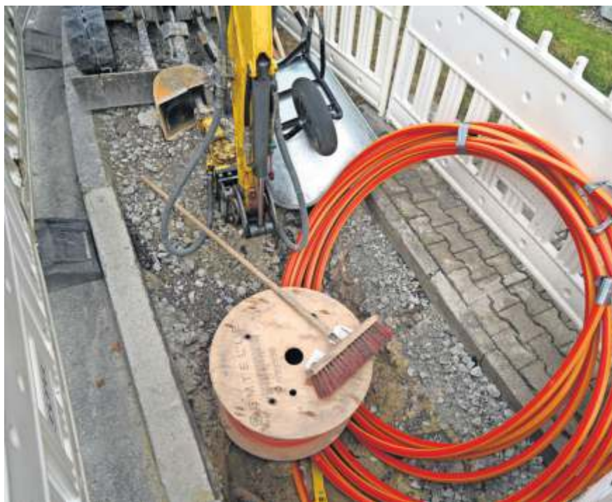
Der Glasfaserausbau in Fellbach geht weiter.
