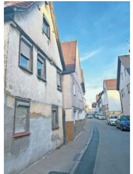
Die Bestandsgebäude im Areal sind abbruchreif. Foto: Küstner
